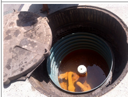
Foto 10: Boca de descarga à área de tancagem com sump.
