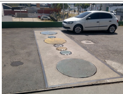
Foto 11: Área de descarga à distância com sump.
