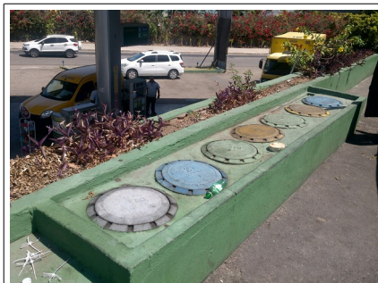
Foto 10: Boca de descarga à área de tancagem com sump.
