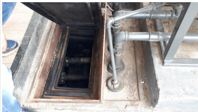
Foto 10: Sump da boca de descarga do tanque, sem dispositivo para descarga selada.
