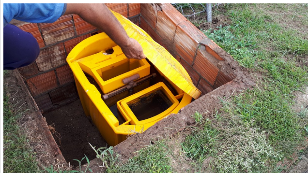
Foto 14: Separador de Água e Óleo 02.
