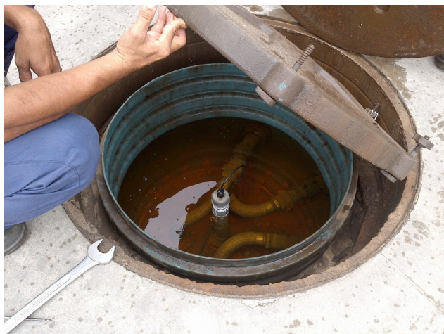
Foto 09: Sump da boca de visita do tanque.
