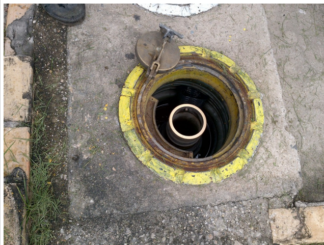
Foto 10: Sump da boca de descarga do tanque, sem dispositivo para descarga selada.
