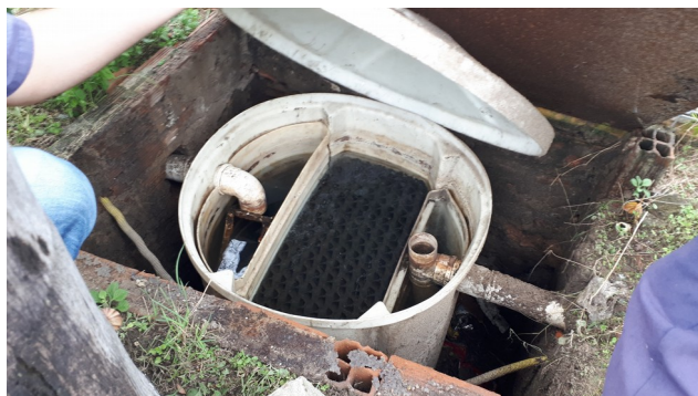
Foto 13: Separador de Água e Óleo 01.
