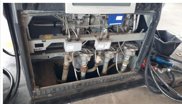
Foto 08: Sump da bomba de abastecimento.
