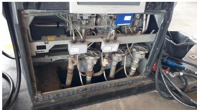
Foto 08: Sump da bomba de abastecimento.
