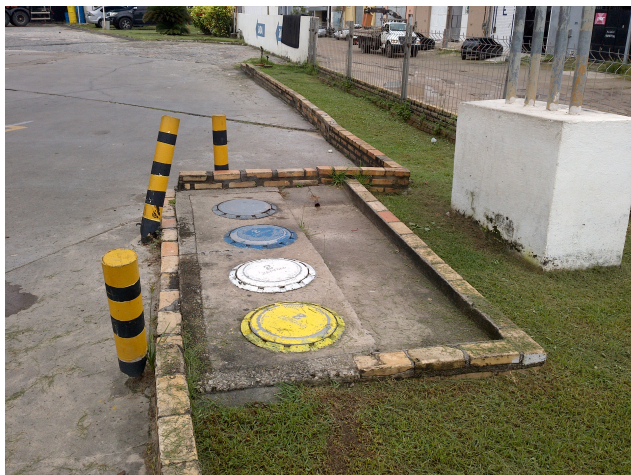
Foto 03: Descarga de combustível à distância.
