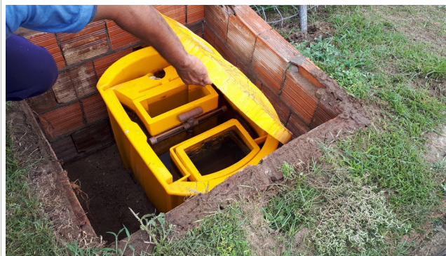
Foto 14: Separador de Água e Óleo 02.
