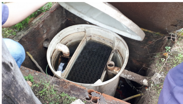
Foto 13: Separador de Água e Óleo 01.
