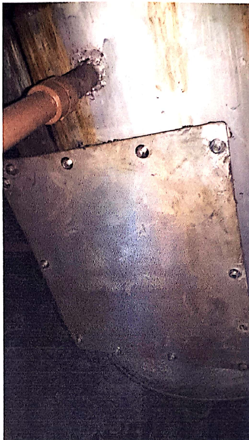
Figura 9 - Detalhe de porta de inspeção do filtro.
