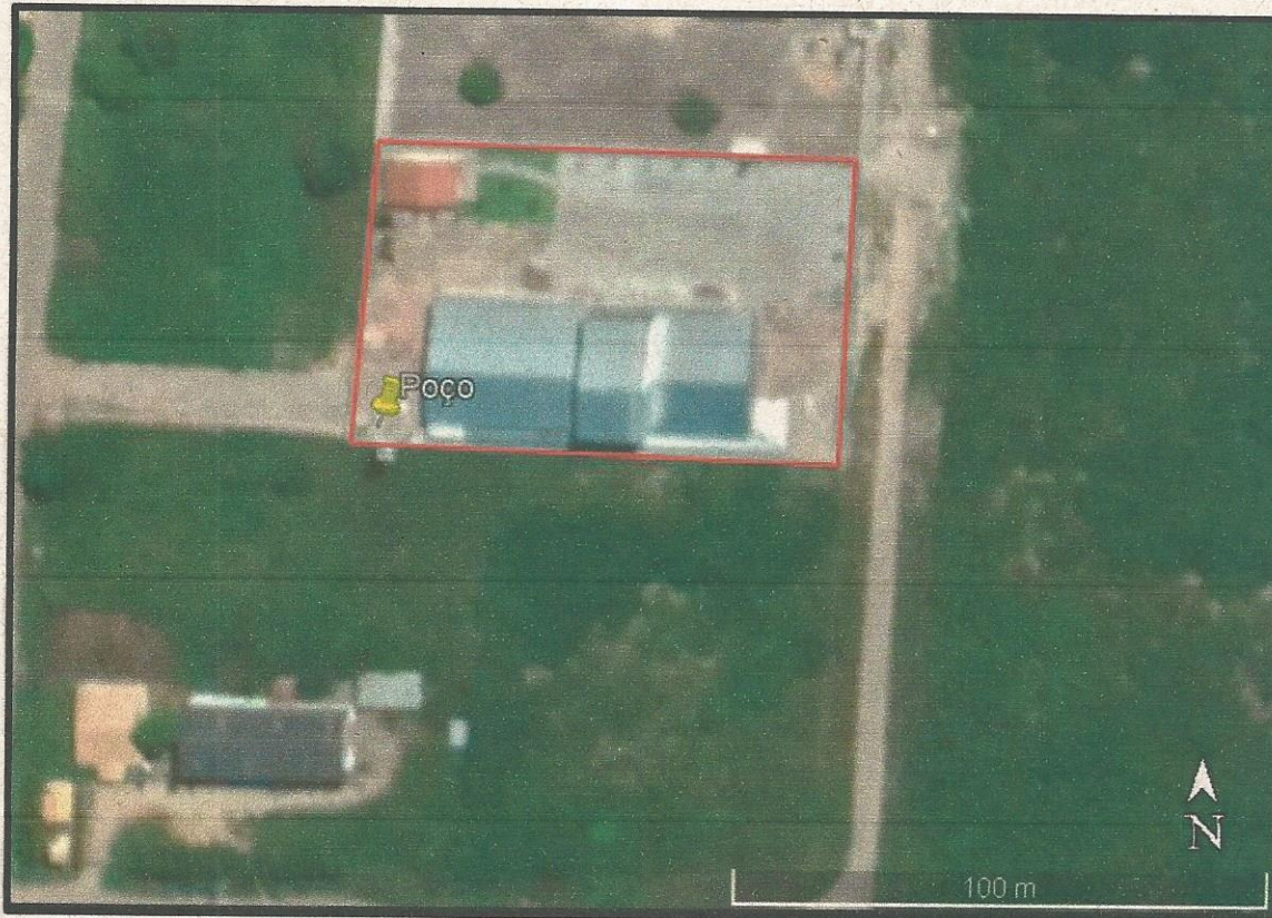
Figura 2. Ponto do poço profundo
