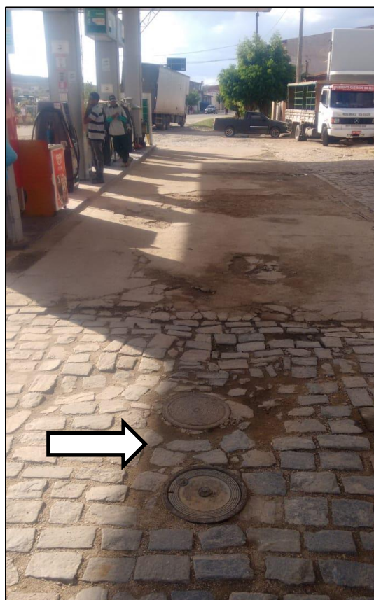
FOTO 04: DISPOSIÇÃO DAS BOCAS DE DESCARGA NA ÁREA DE ABASTECIMENTO
