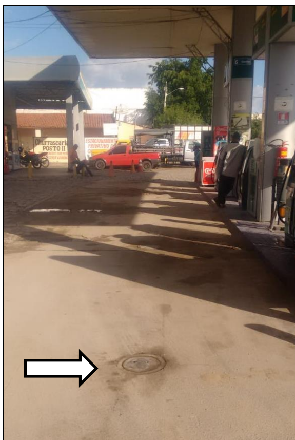
FOTO 04: DISPOSIÇÃO DAS BOCAS DE DESCARGA NA ÁREA DE ABASTECIMENTO
