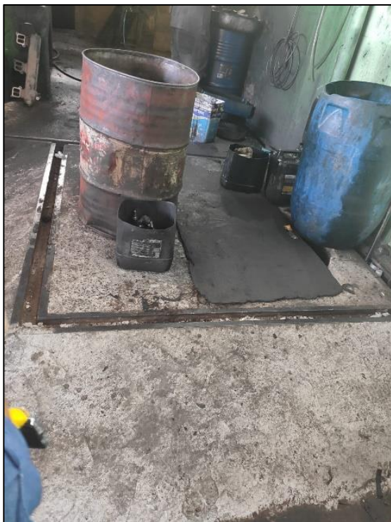
Figura 14 – Caixa Separadora de Água e Óleo.
