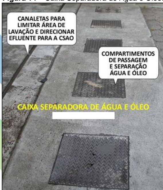
Figura 14 – Caixa Separadora de Água e Óleo.
