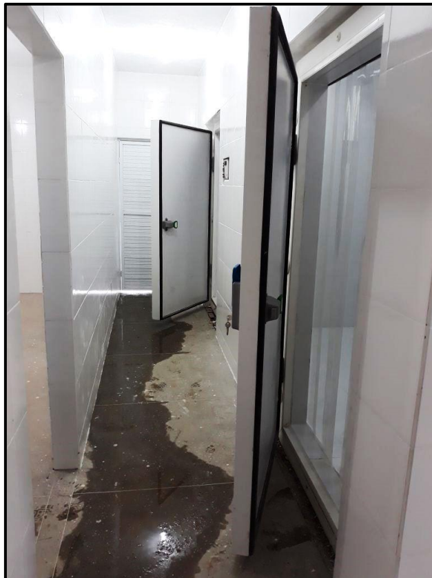
Figura 5 - Câmara de resfriamento e congelamento
