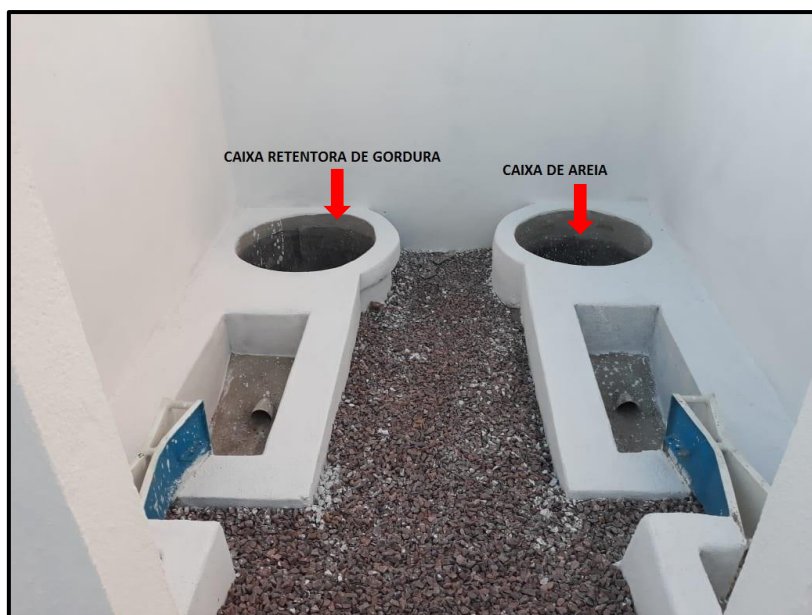
Figura 15 - Caixa retentora de gordura e caixa de areia
