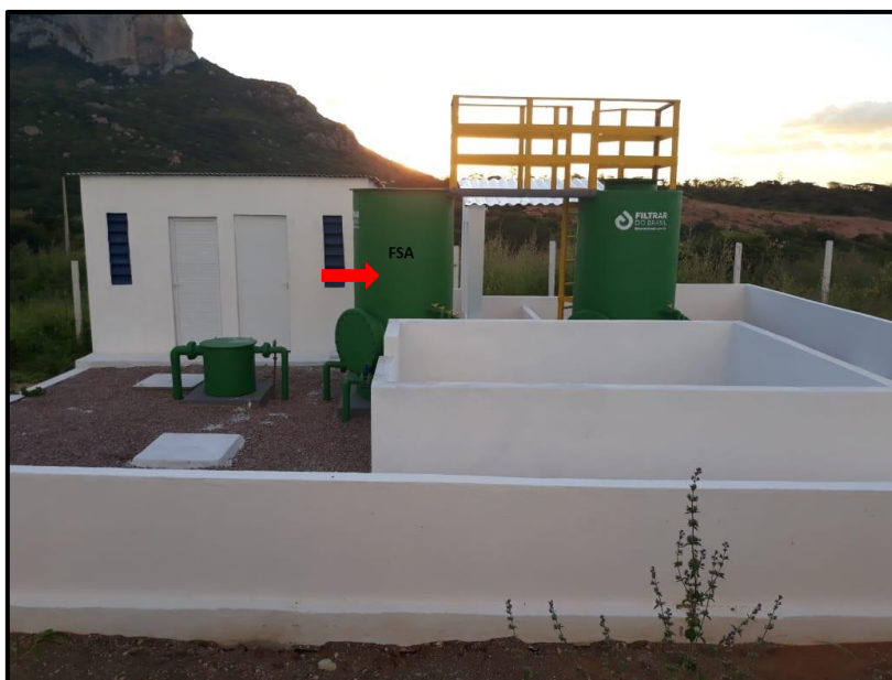
Figura 18 - Filtro Submerso Aerado (FSA)
