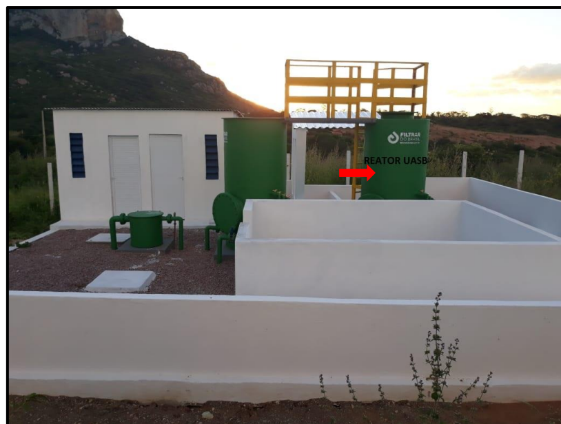
Figura 17 - Reator UASB
