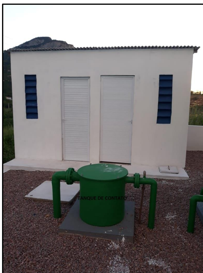
Figura 19 - Tanque de Contato
