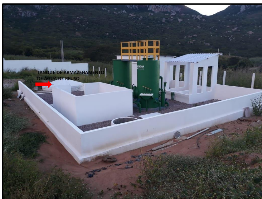
Figura 20 - Tanque de armazenamento de água de reúso
