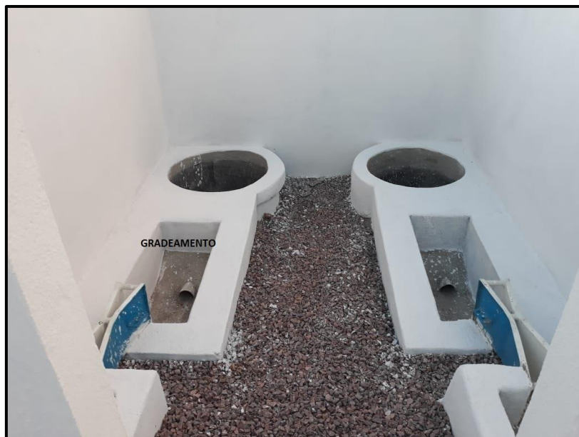
Figura 14 – Gradeamento (obs: as grades serão instaladas quando iniciada a operação da ETE)
