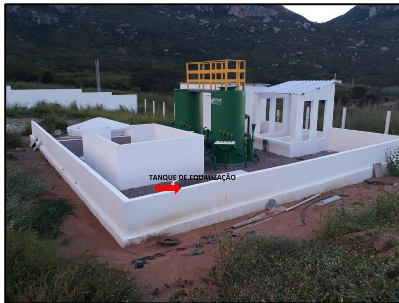
Figura 16 - Tanque de equalização
