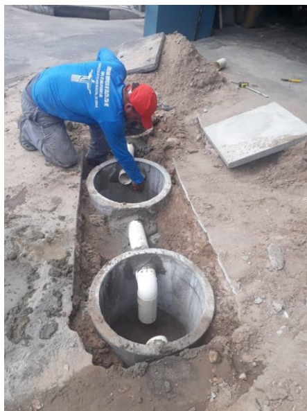
Figura 02 – Implantação sistema SÃO seguido de filtro com lançamento na caixa de passagem da Concessionária CAGECE.
