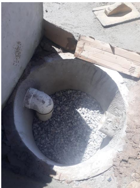
Figura 03 – Implantação sistema de filtro com Areia e brita graduada (fluxo ascendente).
