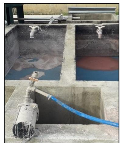
**Sequência 4 –** No tanque equalizador são adicionados agentes coagulantes e floculantes para formação de flocos maiores que sedimentarão e o restante vai para unidade Floco-Decantadora
