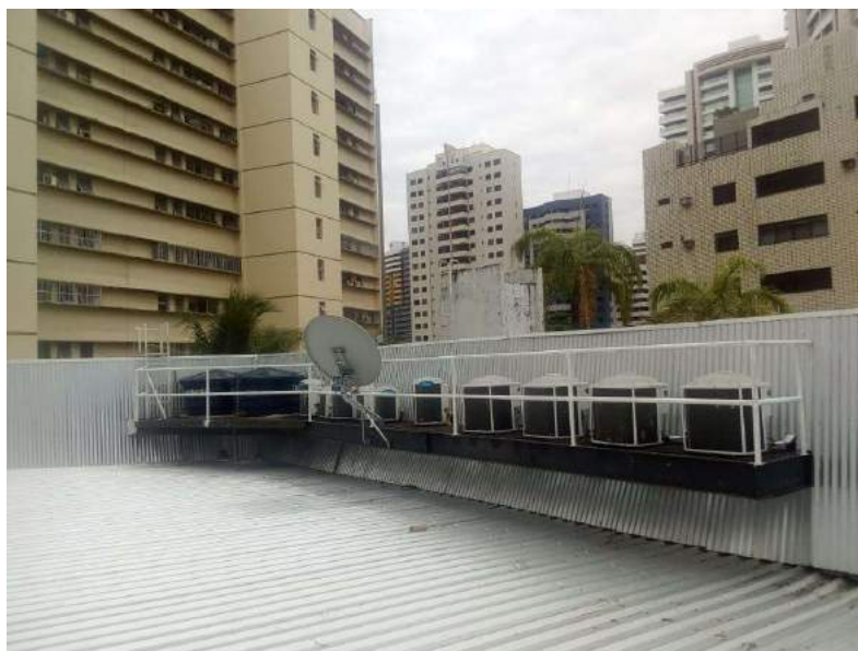
Figura 85 - Laje técnica para caixa d'água e condensadores
