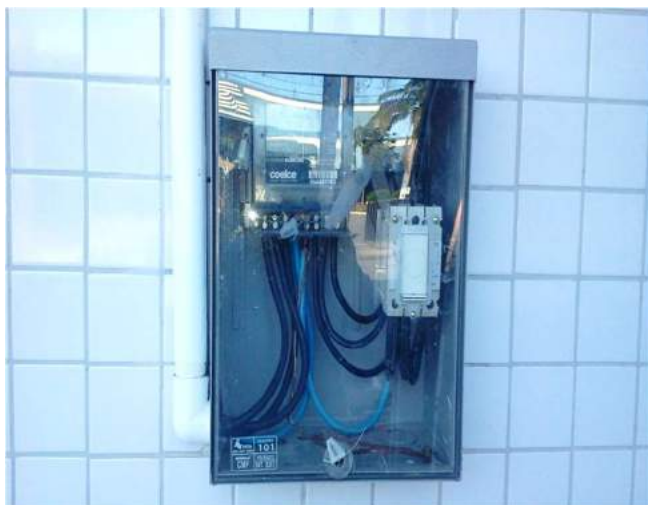
Figura 59 - Quadro de medição.
