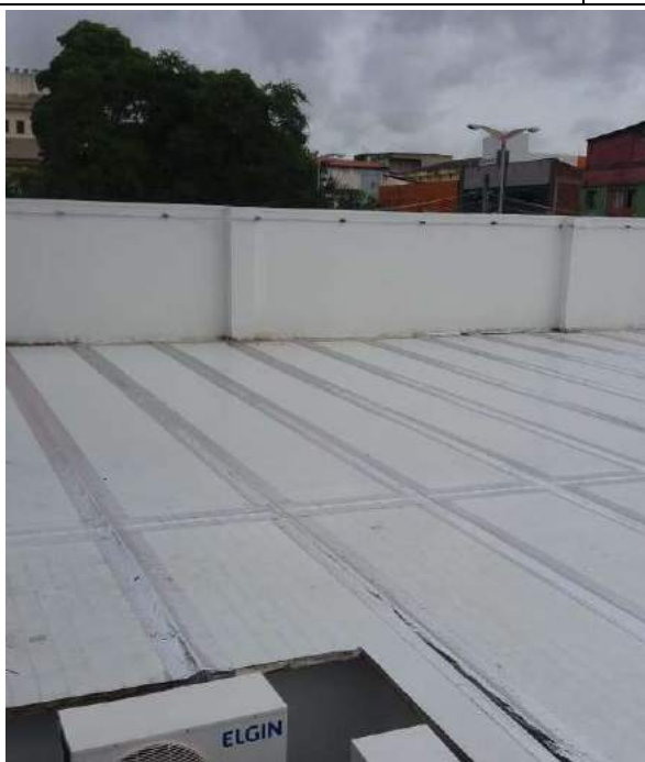
Figura 18 - Coberta com acabamento em Fita Impermeabilizante Multiuso Autoadesiva
