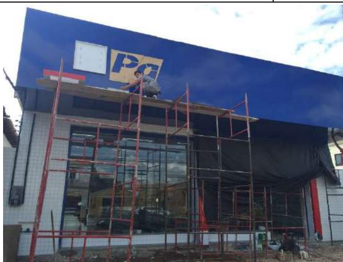
Figura 28 - Fachada em processo de aplicação da logo com uso do gabarito.
