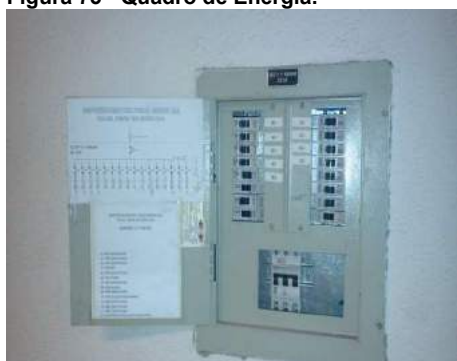
Figura 76 - Identificação dos circuitos na parte interna do quadro.
