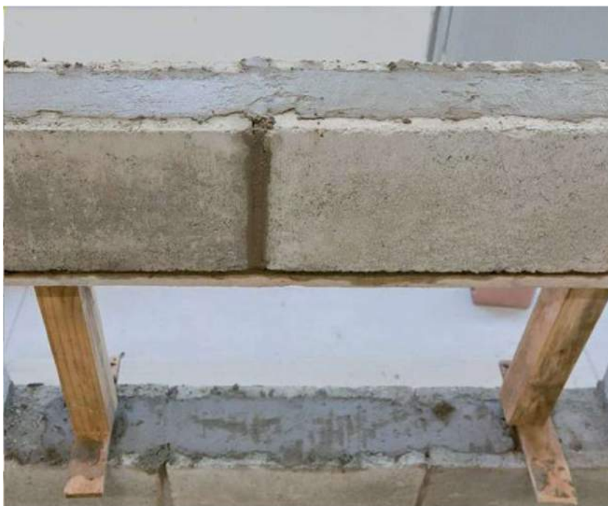
Figura 3 - Verga moldada escorada sobre contraverga
