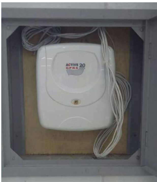
Figura 65 - Quadro de Alarme com ponto de força dentro.
