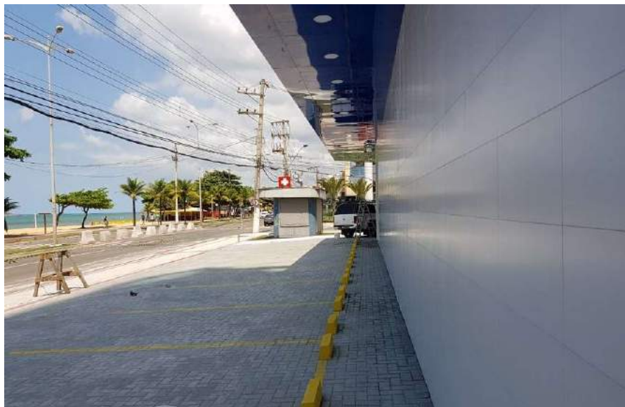
Figura 8 - Estacionamento concluído em piso intertravado.
