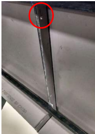
Figura 27 - Detalhe na dobra do ACM azul, com destaque, a fixação por rebite
