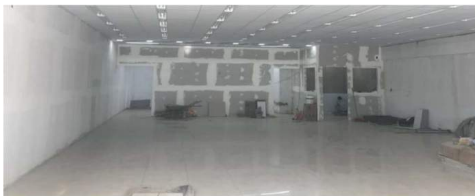
Figura 79 - Divisória de drywall em execução.
