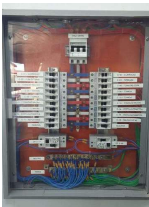
Figura 63 - Quadro de Iluminação nomeado.
