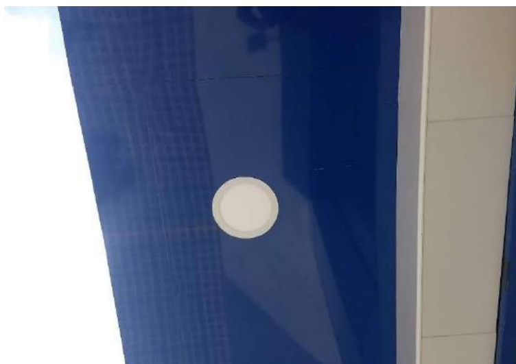
Figura 71 - Luminárias LED, painel circular 18W
