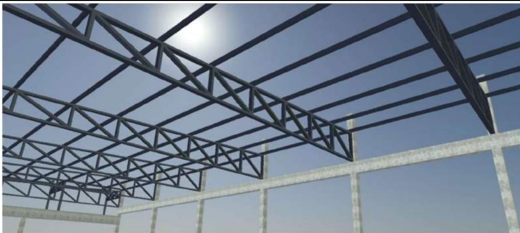
Figura 1 – Apoio Treliças x Pilares de Concreto Armado (conforme o caso)
