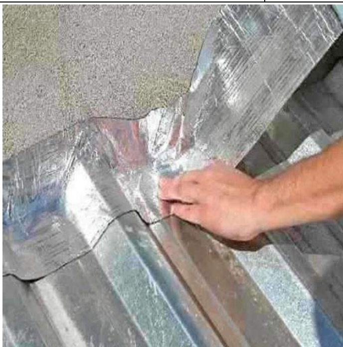
Figura 24 - Rufo lateral em manta Asfáltica Metálica
