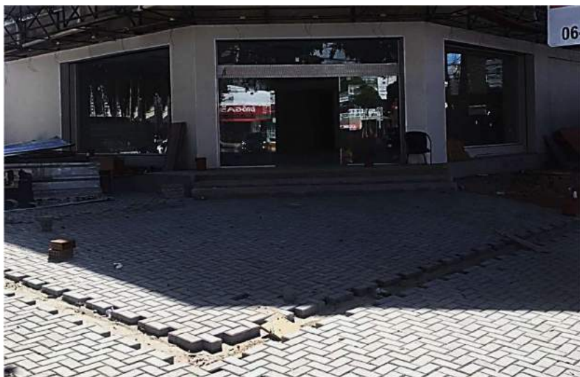
Figura 6 - Estacionamento em Piso Intertravado
