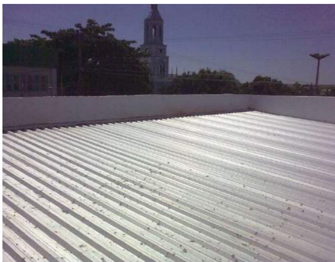
Figura 19 - Telha trapezoidal
