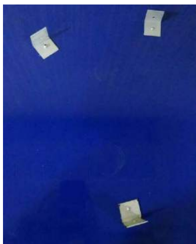
Figura 29 - Placa de ACM azul com cantoneiras para fixação das letras caixa.
