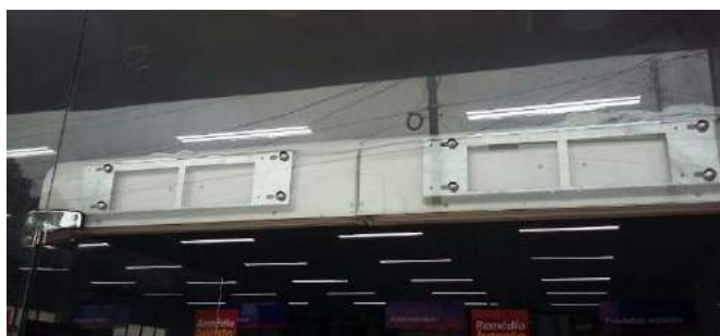
Figura 83 - Fixação da Cortina de ar por botões.
