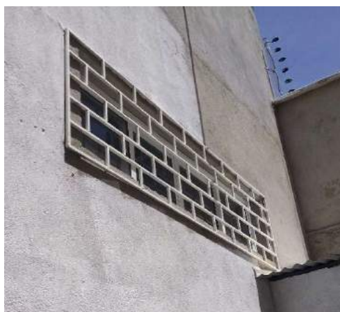
Figura 38 - Janela com gradil externo pintado na cor branco e malha estilo tijolinho.
