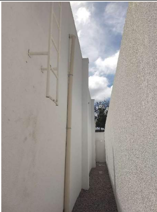
Figura 9 – Área externa em textura acrílica.
