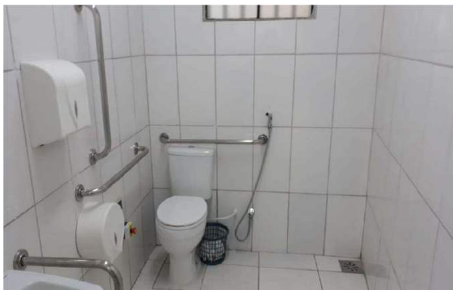
Figura 46 - Barras de apoio
