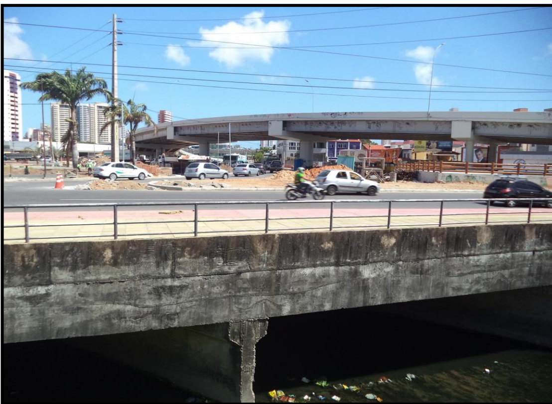
Figura 15. Canal do Tauape. Trecho impermeabilizado.
