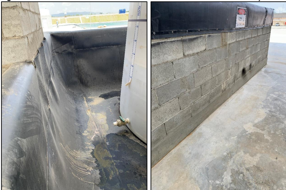
Figura 24 – Manta sintética de revestimento e base de concreto da bacia de contenção.
