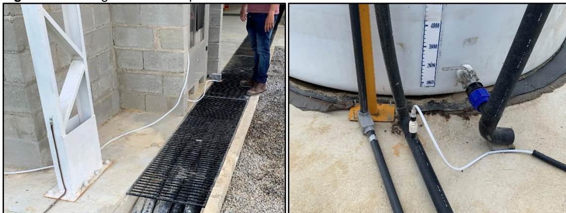
Figura 25 – Mangueira de transporte de ácido sulfúrico.
