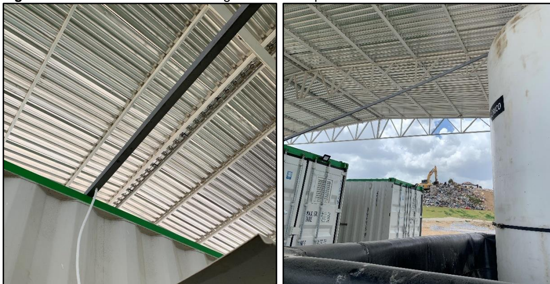
Figura 26 – Canaleta contendo mangueira de transporte de ácido.
