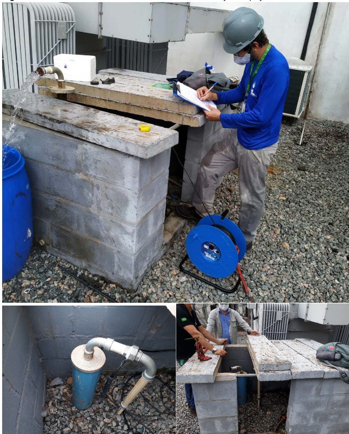
Figura 6 – Procedimentos do teste de bombeamento e situação do poço.
