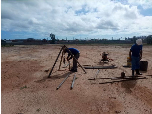
Foto 01 - Detalhe da montagem da torre de sondagem a percussão.
