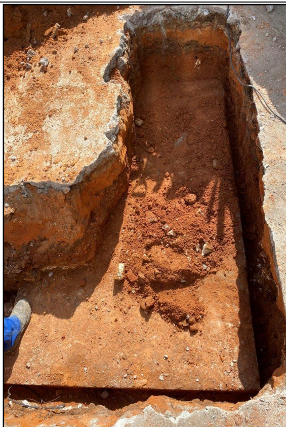
Local de instalação da fossa séptica e sumidouro
