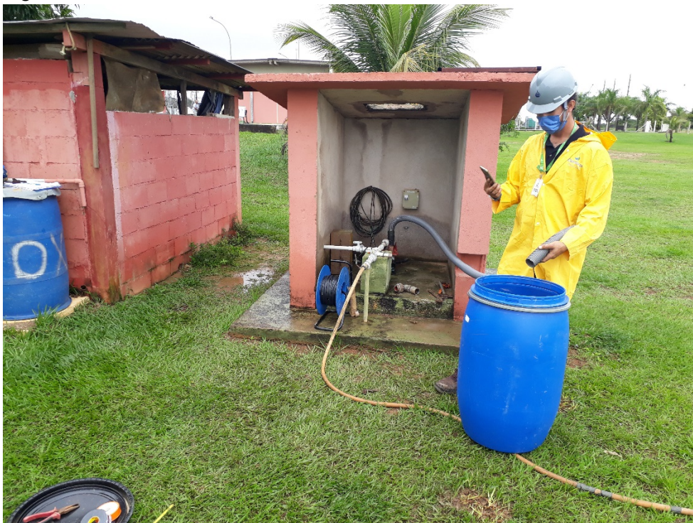
Figura 4 - Teste de vazão em reservatório de 100 litros
