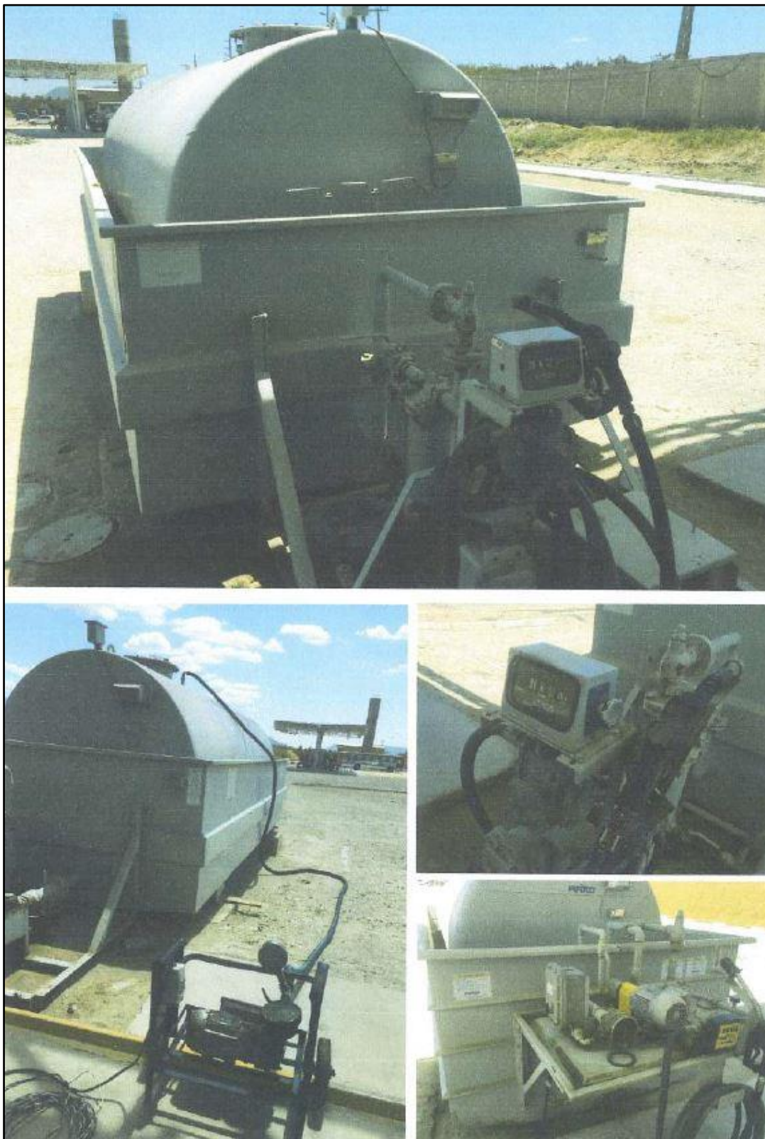
Figura 8: Detalhes dos tanques aéreos de armazenamento.
