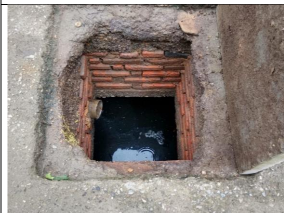
Figura 5: Sistema de fossa e sumidouro em ótimo estado de conservação da Área Operacional
