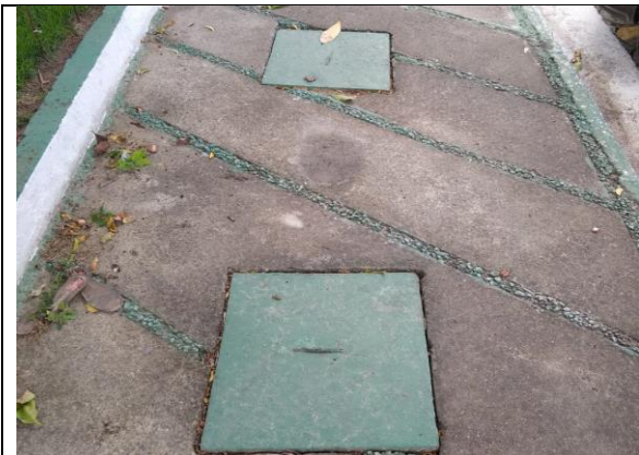
Figura 3: Sistema de fossa e sumidouro da Área Administrativa com tampas hermeticamente fechadas
