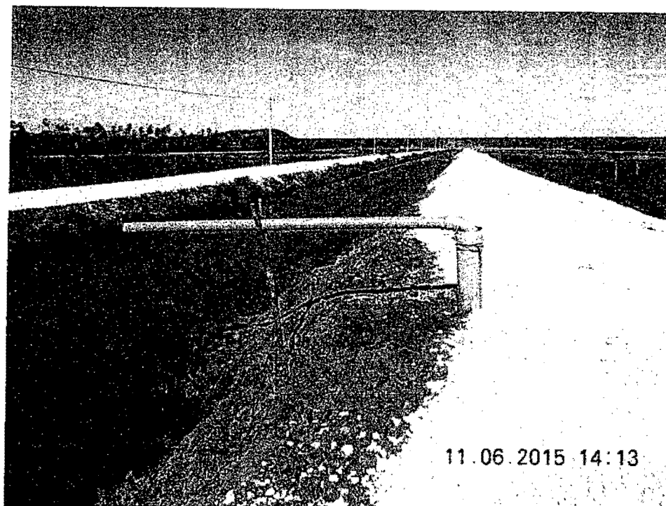
Foto 01 – Poços que alimentam o canal artificial no centro do empreendimento.
