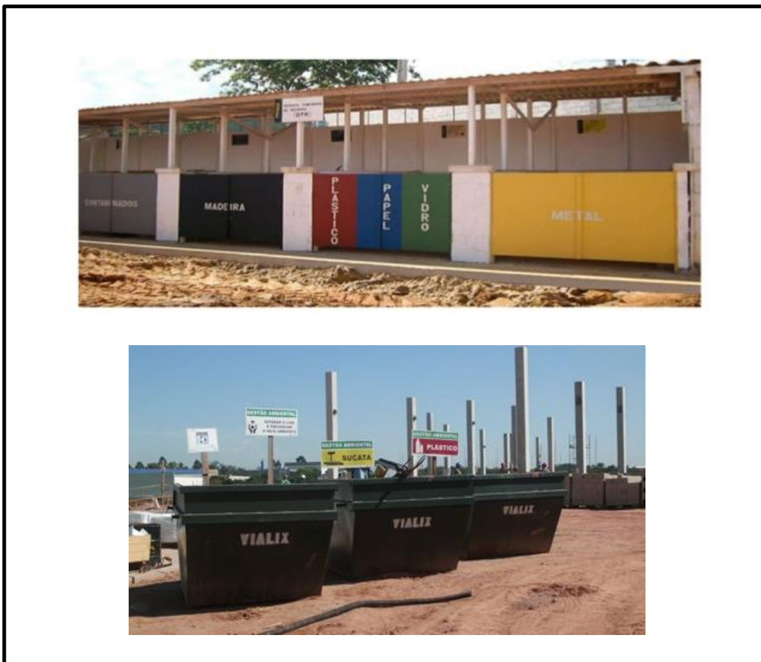
Figura 3 - Modelos de coletores de acordo com a Resolução CONAMA 275/2001.
