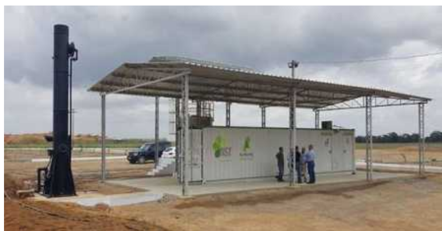
Fotografia 2: Imagem do Contêiner e da Chaminé, com o Lavador de Gases, do Sistema de Tratamento por Osmose Reversa da Estação de Tratamento dos Efluentes - ETE do Lixiviado (Chorume) gerado no Aterro Sanitário Metropolitano Oeste de Caucaia - ASMOC II.
