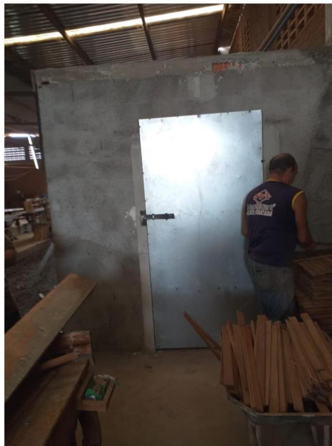
Isolador acústico para os geradores
