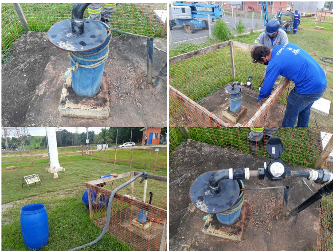
Figura 5 – Poço tubular da subestação Jaru.
