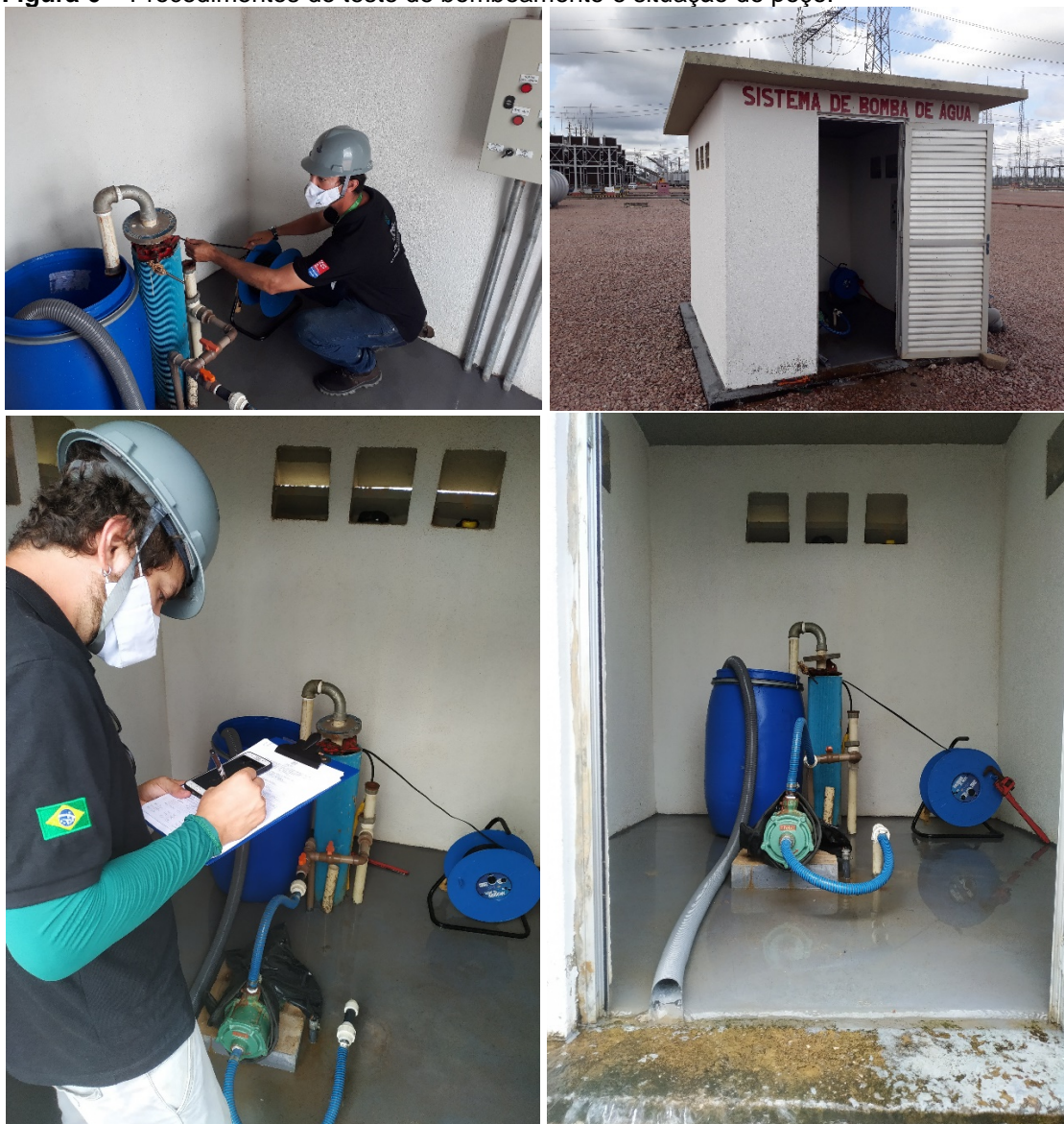
Figura 6 – Procedimentos do teste de bombeamento e situação do poço.
