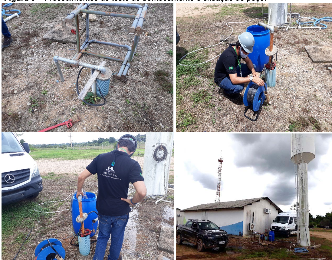
Figura 6 – Procedimentos do teste de bombeamento e situação do poço.
